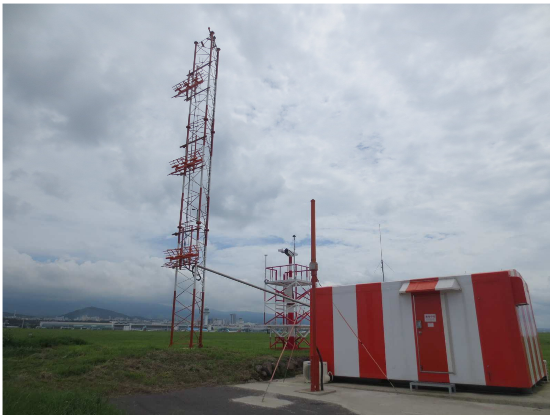
Рис. 2 Внешняя многовибраторная сложная антенна РМГ
